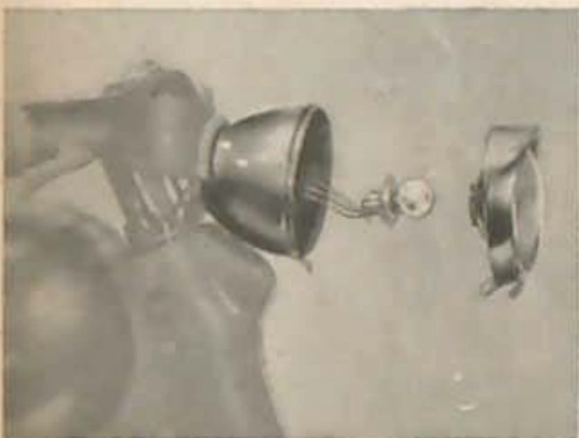
Abb. 25 Scheinwerfer demontiert
