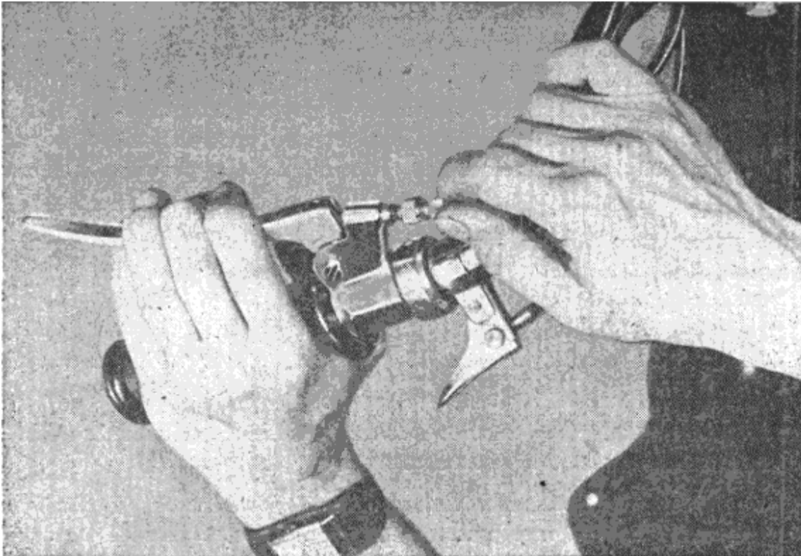
Obr. 15. Seřízení vůle lanka spojky.
